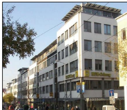
Doberaner Straße, Rostock
