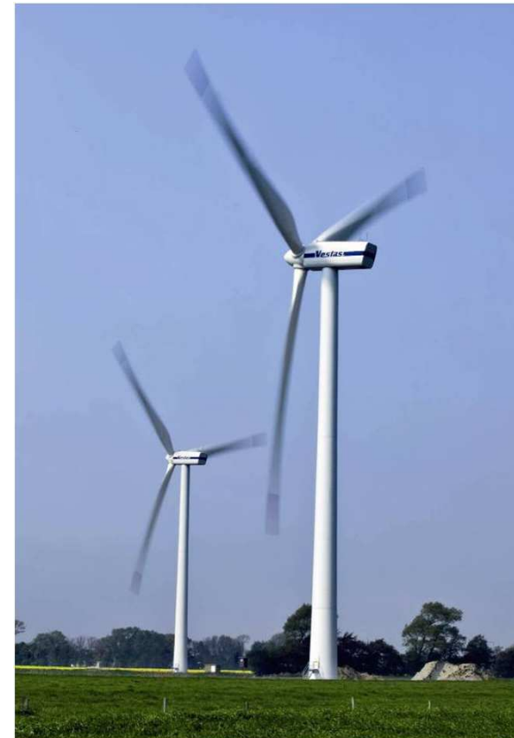
Windpark Altenbruch II
