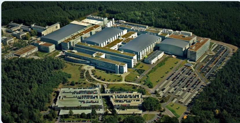
Dresden (Germany) site
