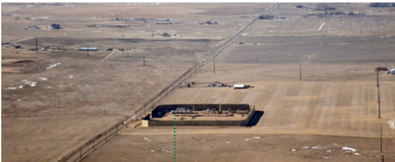
• LUFTBILD EINES BOHRPLATZES IN COLORADO
