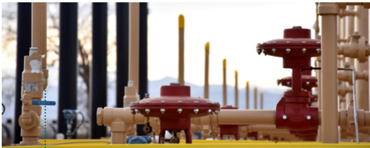
• EINE ANLAGE ZUR SEPARATION VON ÖL, GAS UND WASSER IN COLORADO
