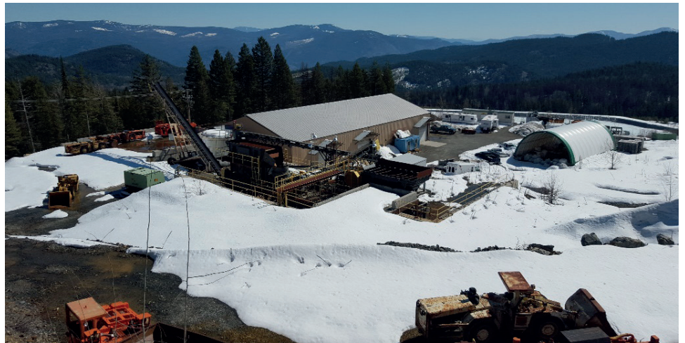
Die Greenwood Verarbeitungsanlage wurde 2008 installiert und ist in einem entsprechend gutem Zustand
