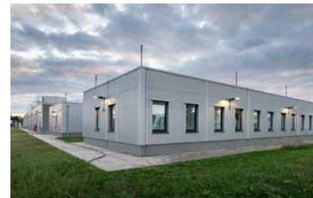
Rechenzentrum Leipzig: 1.400 m 2 , PUE-Zielwert 1,2
