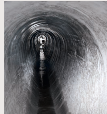
Innenansicht des sanierten Hauptsammlers
